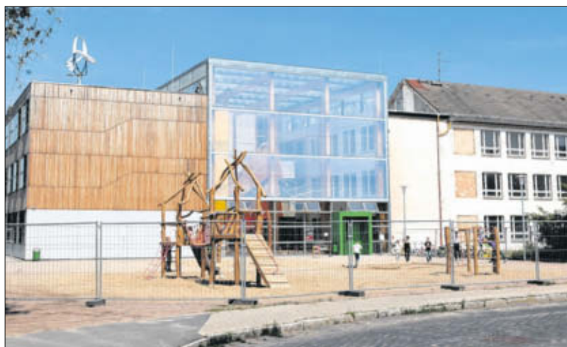
Der Grundschulteil links lässt erahnen, dass sich das Warten doch noch lohnt – rechts der noch unsanierte Teil fürs Gymnasium.
